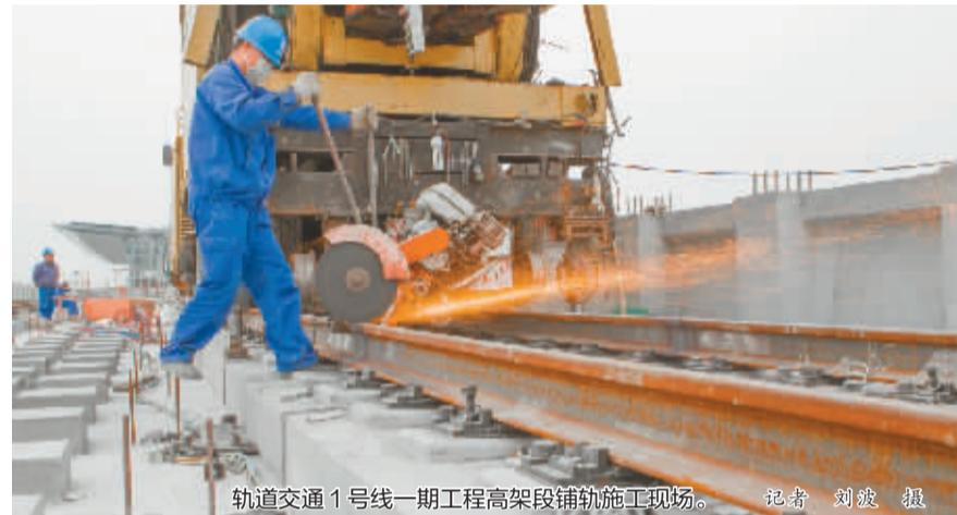
轨道交通1号线一期工程高架段铺轨施工现场。记者 刘波 摄
