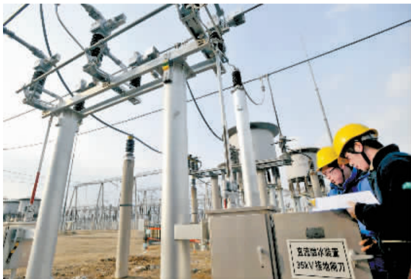
昨天下午,投入6000万元的电力直流融冰设备在我市供电部门首次投入使用。据介绍,昨天我市山区高压线路出现冰冻,使用这套设备通过加大电流使导线发热,进而融化冰雪、保护线路。
