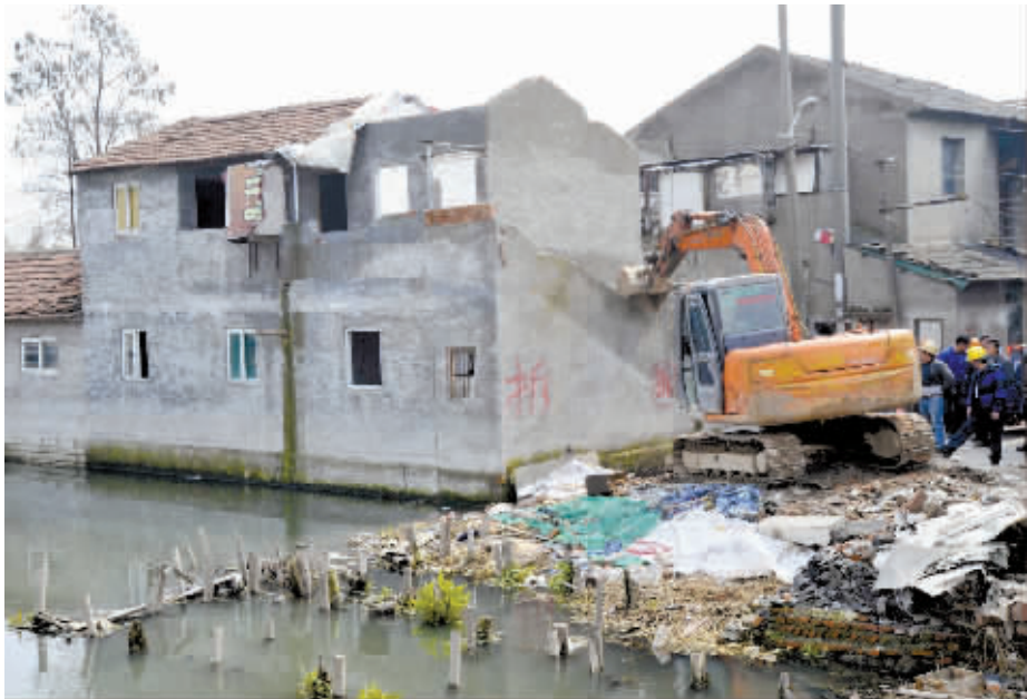
昨天,有关部门在拆除童王河旁的违法建筑。 记者 王增芳 摄
