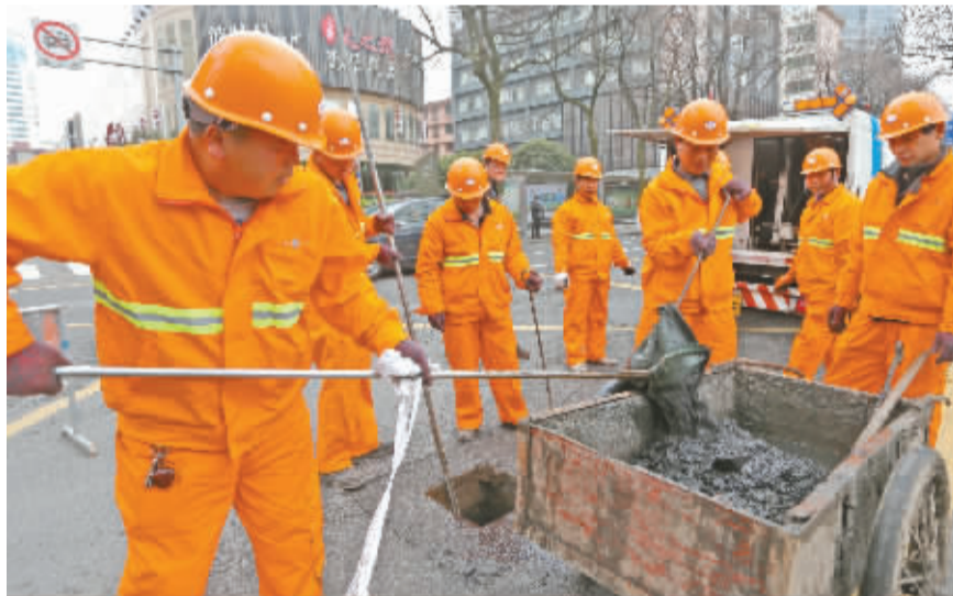
工作人员在清理污水管中的淤泥。
