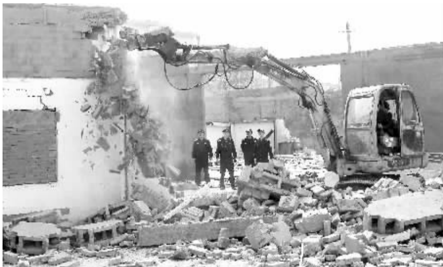
有关人员在拆除铁路沿线违建建筑。
