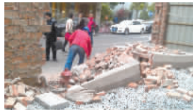
挡住君子街消防栓的违法搭建墙体被拆除。
