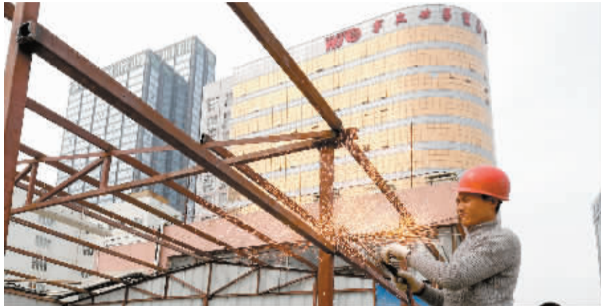
昨天下午，有关人员在拆除违法建筑。
