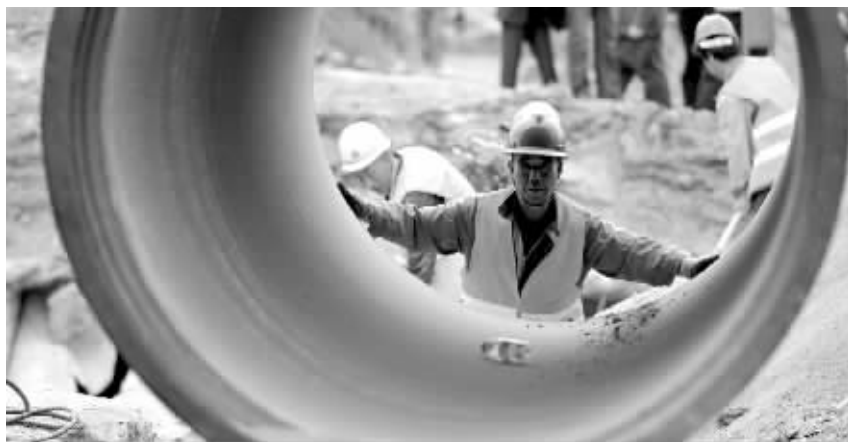
图为14日兰州市在对发现苯超标的两条自流沟管道进行重新敷设。 据新华社
