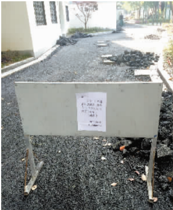
丹顶鹤小区沥青路面返工。
