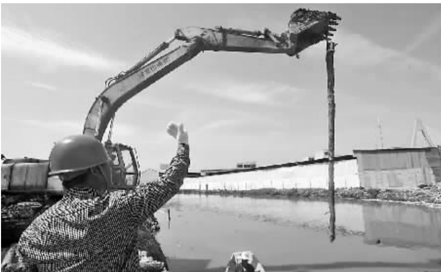
昨天下午,施工人员打下第一根护岸木桩。
