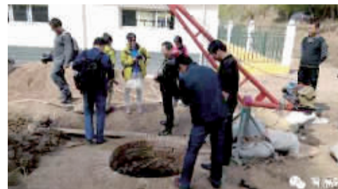
先锋小学水井施工现场。
