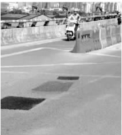
庆丰桥桥面上被修复的坑。 廖业强 摄
