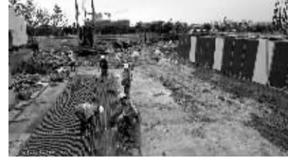
前天，连接东西段永达路的澄浪桥及接线工程正在紧张施工。根据计划，大桥将于明年底完工。大桥的海曙侧引桥长90米，江东侧引桥长173米。大桥设置双向机动车六车道及非机动车道、人行道，设计速度为每小时40公里。
