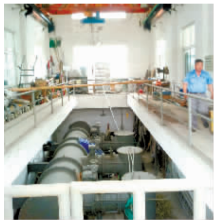
两层建筑其实为泵站用房。
