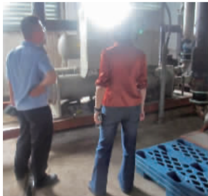
机器下面红色的杠就是减震装置。
