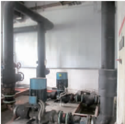
机房墙上基本覆盖了隔音棉。
