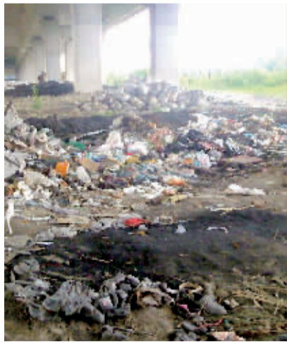
高架桥下垃圾成堆。
