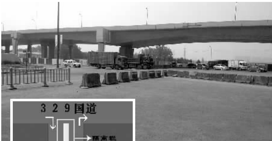
上图:梅竹路和329国道交接处设有围挡。陈结生 摄 左图:梅竹路和329国道交叉口示意图。
