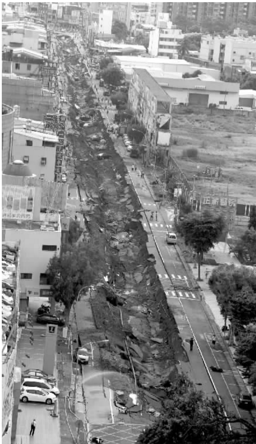
事发街道路面被破坏 新华社
