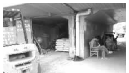
铁路桥桥洞内堆放着水泥等材料。
