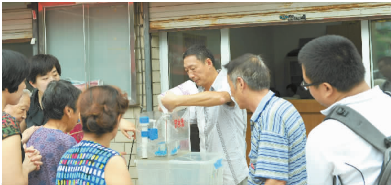
8月15日，市城管局公用事业监管中心会同江北区城管局在百合社区开展了社区居民节水器具改造活动，现场向市民发放了100多套节水阀，并入户帮助市民进行安装、调试。
