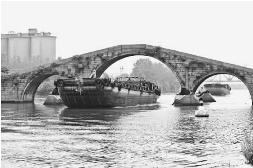
嘉兴, 城北运河上的长虹桥。乾隆下江南时, 此桥曾为接驾处。它是大运河上至今仍在使用的三座大型石拱桥之一。
