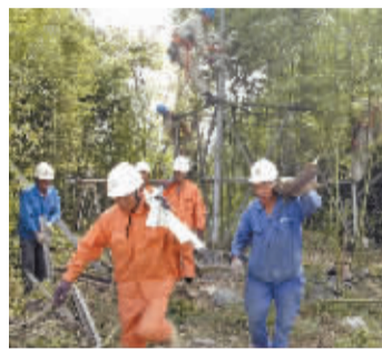
昨天,鄞州供电公司工人在五乡镇宝幢拆除电力铁塔。为了轨道交通1号线二期工程(邱隘至北仑)安全施工需要,鄞州供电公司组织力量对跨越轻轨高架段的2座高27米铁塔和540米电力架空线全部拆除,改建电缆落地工程。徐文杰 胡春华
