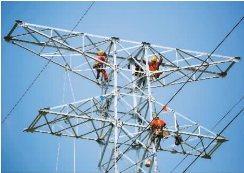
电力工作人员正在检修送变电洪塘工程。
