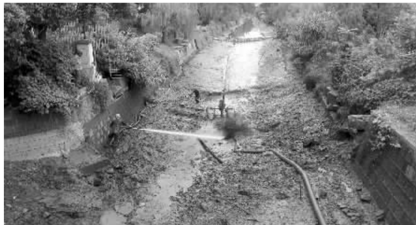
昨天上午, 施工单位在疏浚马家河。
