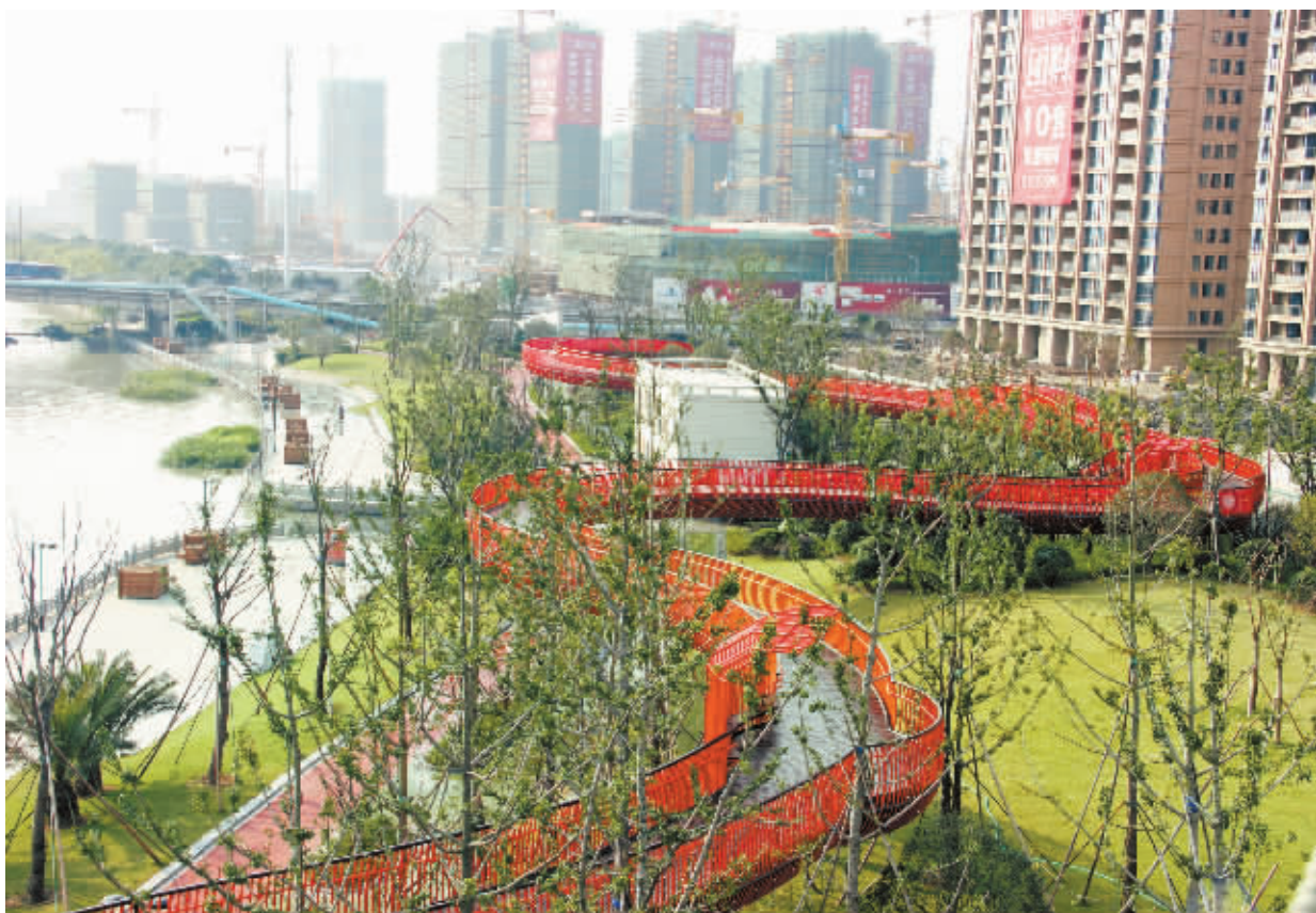
姚江北侧滨江绿化景观工程项目的空中走廊。
