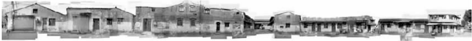
大桥街西立面北段现状
