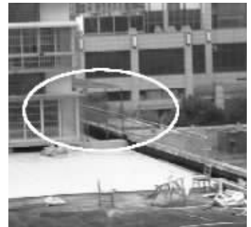
平台铺了瓷砖,东面搭建了雨棚。
