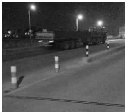
已安装好的警示桩。
