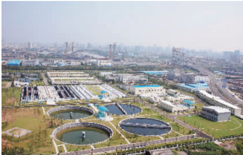
现代化的南区污水处理厂日处理能力24万吨，是宁波最大的生活污水处理厂。
