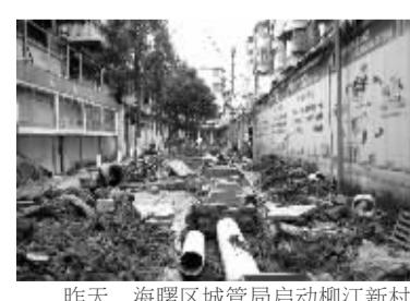
昨天，海曙区城管局启动柳汀新村和马园新村雨污分流改造工程。这是该区今年最后两个老旧小区雨污分流改造工程。两个工程涉及居民1500户，均计划在明年1月底前完工。
