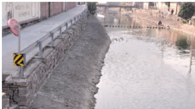
姜贤友修建好的河堤
