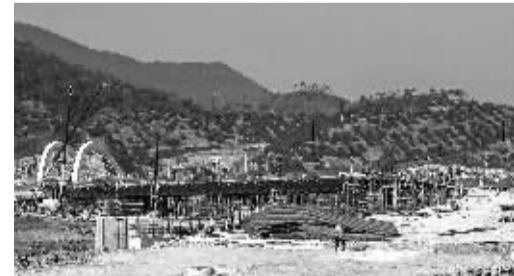
新年伊始，象山大目湾新城玉界桥成功合龙，目前正在进行桥面栏杆等辅装作业。玉界桥全长325米，双向两车道，由二组桥梁组成，形状如“鲤鱼跃龙门”。其中“鲤鱼”部分已于去年5月建成通车，连通大目湾至松兰山景区隧道。目前合龙的“龙门”部分，是大目湾横跨内湾的首座桥梁，其中闸门工程创象山县跨度最大和单孔跨径最大。整个桥梁工程将于5月底完工并试通车。
