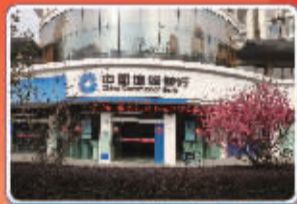
建行宁波锦城支行 地址:宁波市杨木碇路184号
