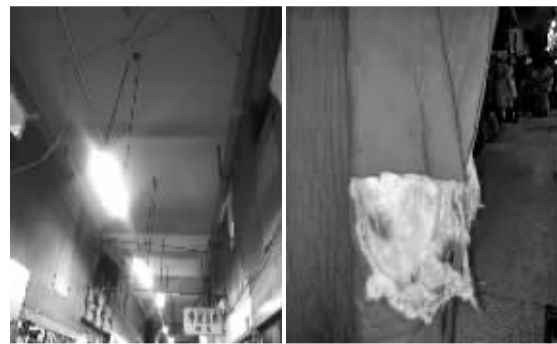
网友“打鱼者”反映:轻纺城电线老化乱接(左图),门帘是棉花类易燃物(右图)。
