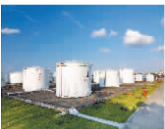
中石化宁波石油分公司三官堂油库罐区。
