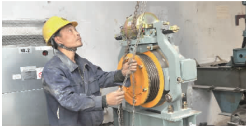
昨天下午，电梯安装工正在安装新电梯。 记者 王增芳 摄
