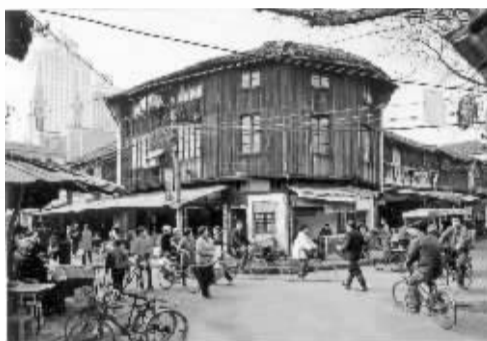
碶闸街咸塘街口
