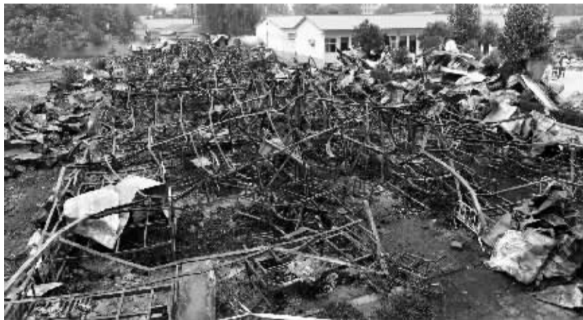
5月26日拍摄的火灾现场。
