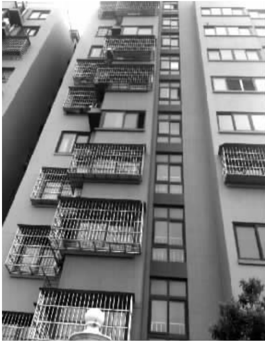
经常发生高空抛物的小区住房。
