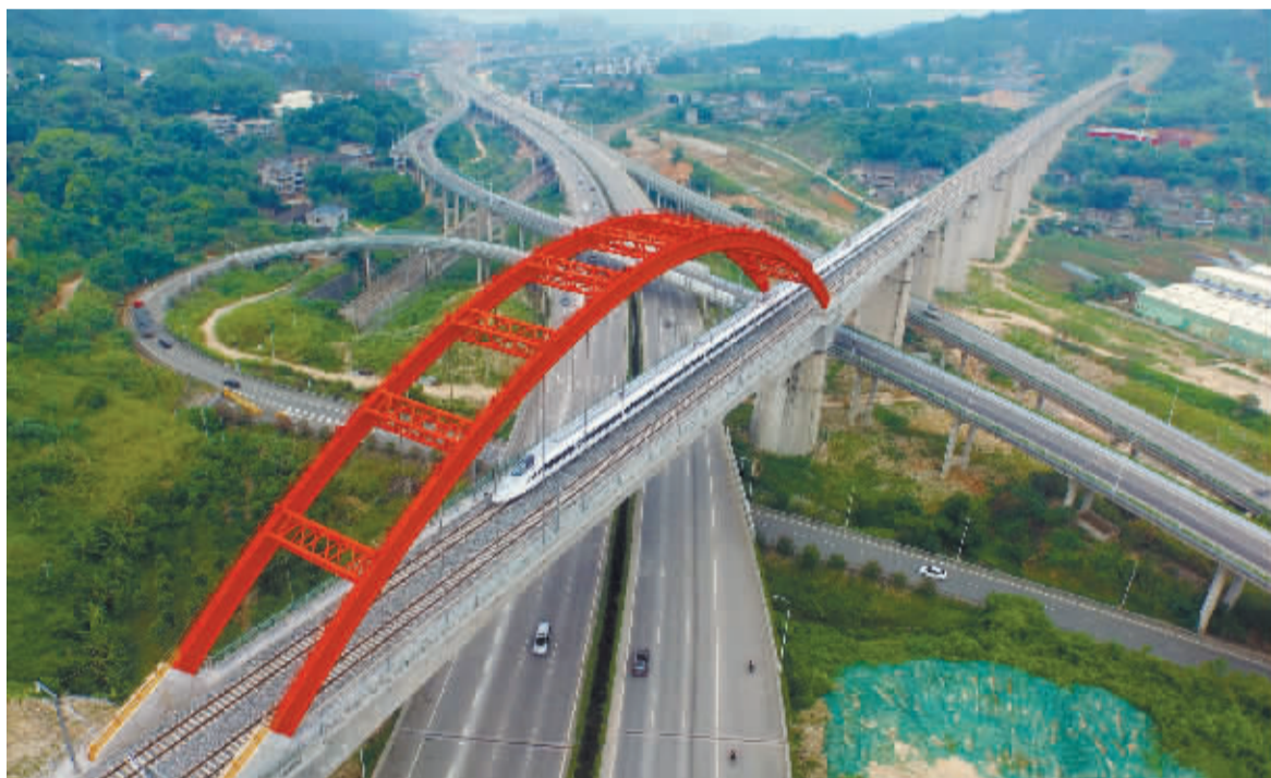
6月28日,福州开往合肥南的G2626次高铁列车经过福州境内的跨西岭互通特大桥。
