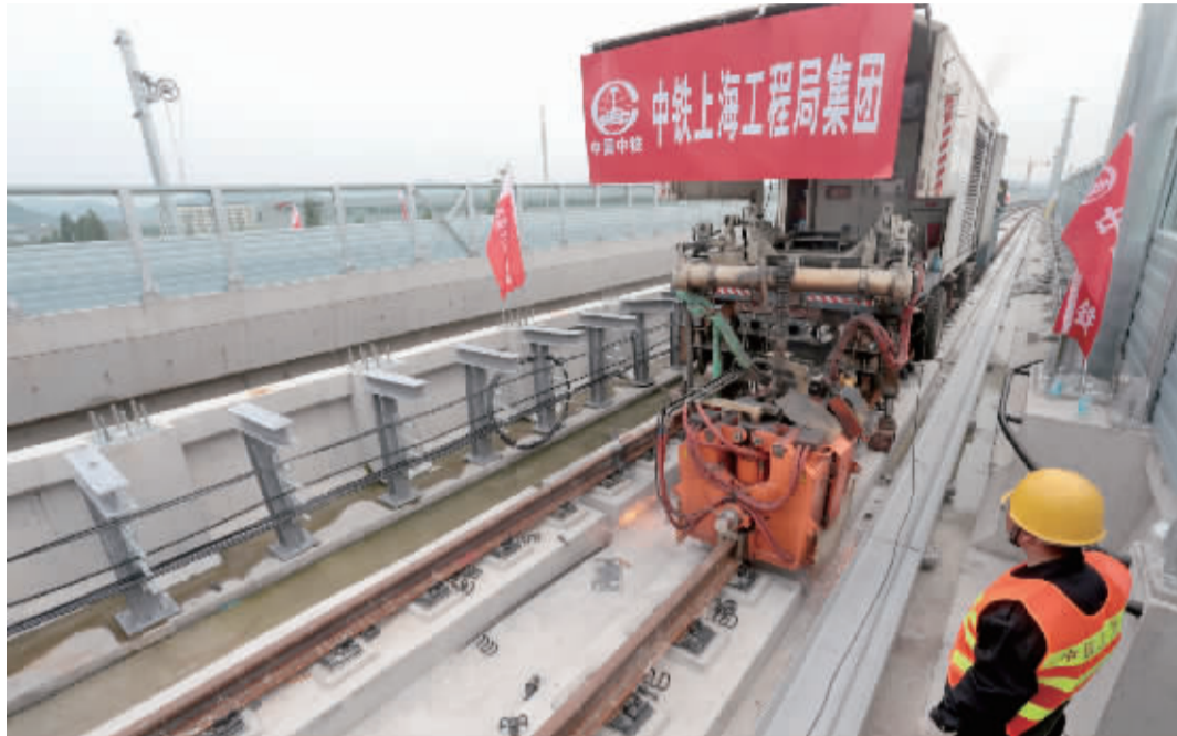
昨天下午，随着宝幢站左线站台区最后一处钢轨合龙接头焊接完成，宁波轨道交通1号线二期工程正线轨道全线贯通。 记者 刘波 摄
