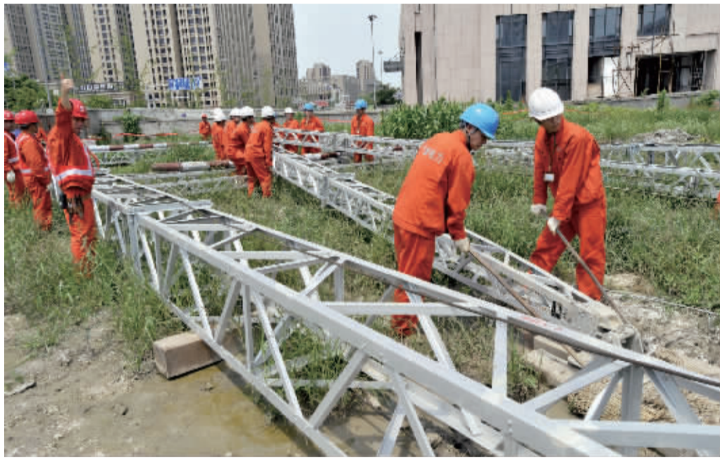
市区一处空地,宁波电力工人正在临时搭建铁塔。 记者 王增芳 摄
