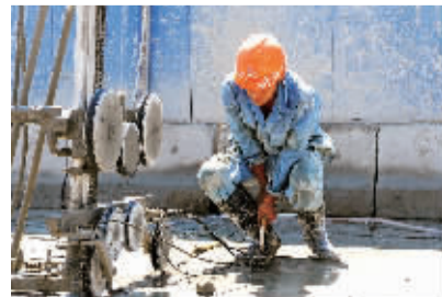
8月5日，在轨道交通2号线轻纺城站建筑工地，工人在高温下作业，干劲十足。徐志焕 摄
