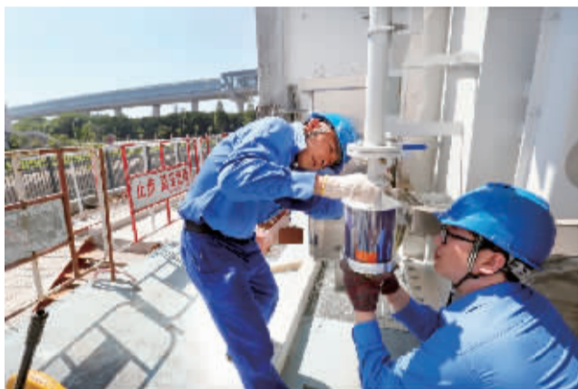
轨道交通2号线，在双桥变，电力工作人员正在加紧安装电气设备。
