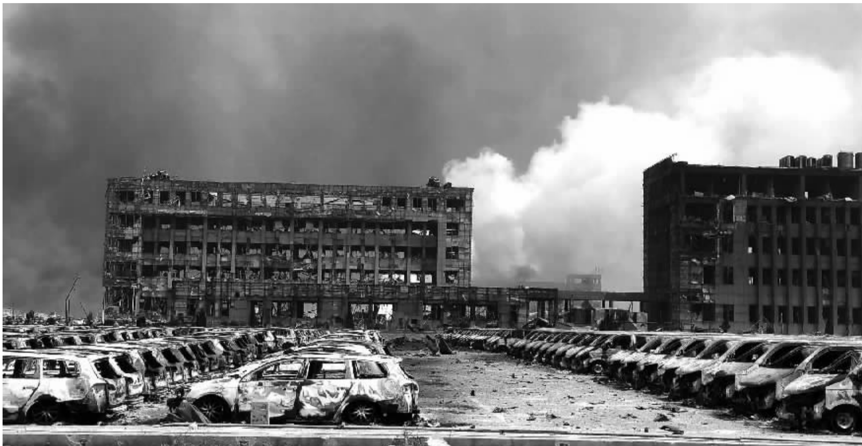
8月13日，在天津滨海新区危险品仓库爆炸事故核心现场，附近数千辆车被烧毁。
