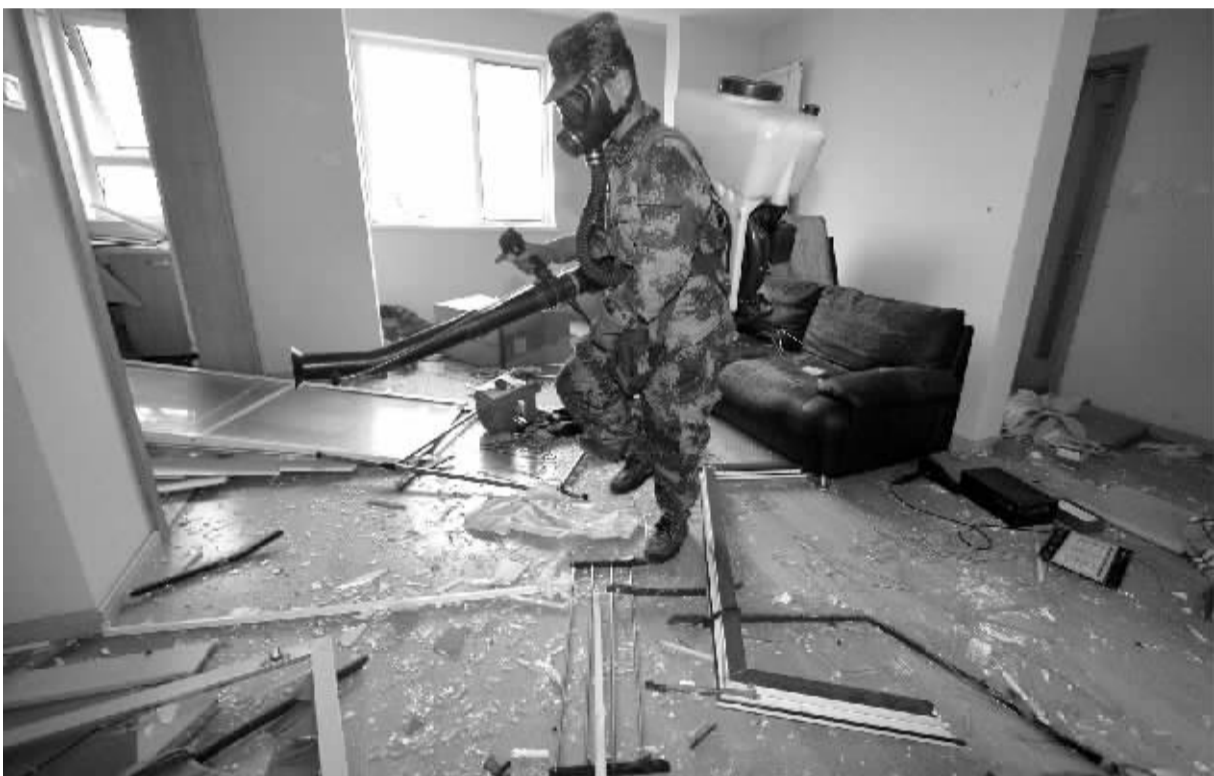
8月18日，国家核生化应急救援队官兵在海港城等事故核心区周边居民区开展洗消作业。
