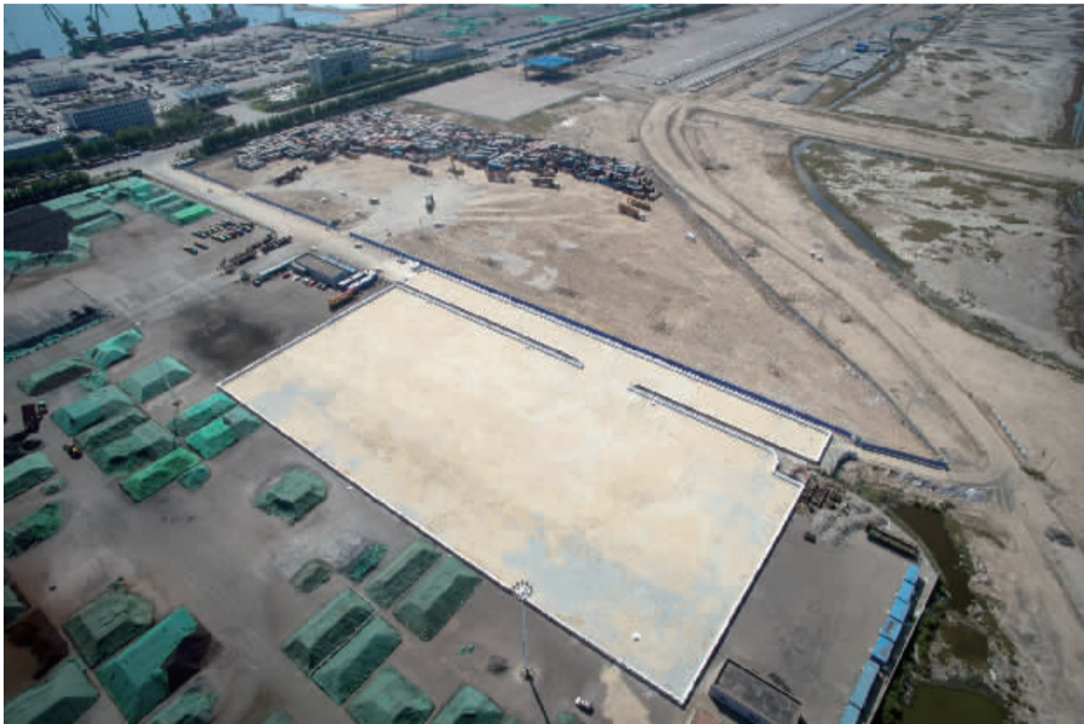
日前，一个占地总面积约2万平方米的防渗池在距离天津港爆炸事故核心区约4公里处的天津港海铁一号路建成，用于存放从事事故现场清理出的污染土。这是8月27日拍摄的防渗池。 新华社
