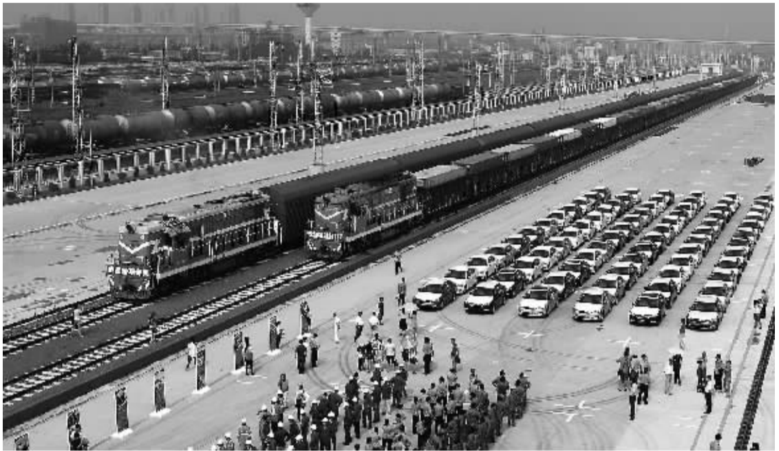
铁路北货站是海铁联运的重要节点。记者 刘波 摄
