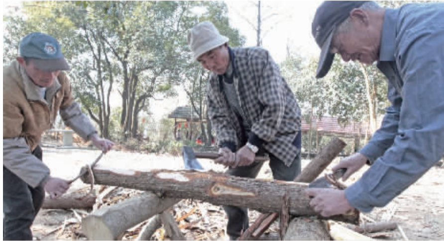
袁松才(中)等人在修整木料, 准备搭建凉亭(资料照片)。
