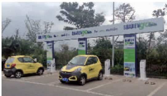
宁海金海大酒店门前的电动汽车充电站点 记者 陈韬 摄
