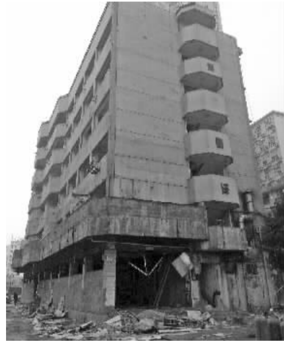
已开拆的宁波建材大厦。
